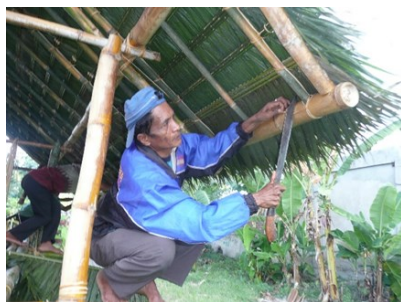
山刀一本で家を組み立て、屋根を葺く [2008年1月]
